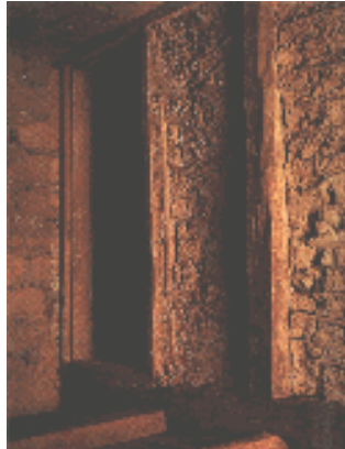
DETALHE DA CONSTRUÇÃO INICIAL
