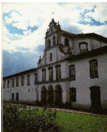
FACHADA DO MOSTEIRO
